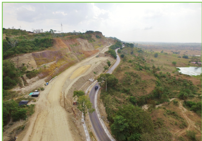
Frente de Obra: Segunda calzada Sincelejo - Tolviejo, sector Sierra Flor.
